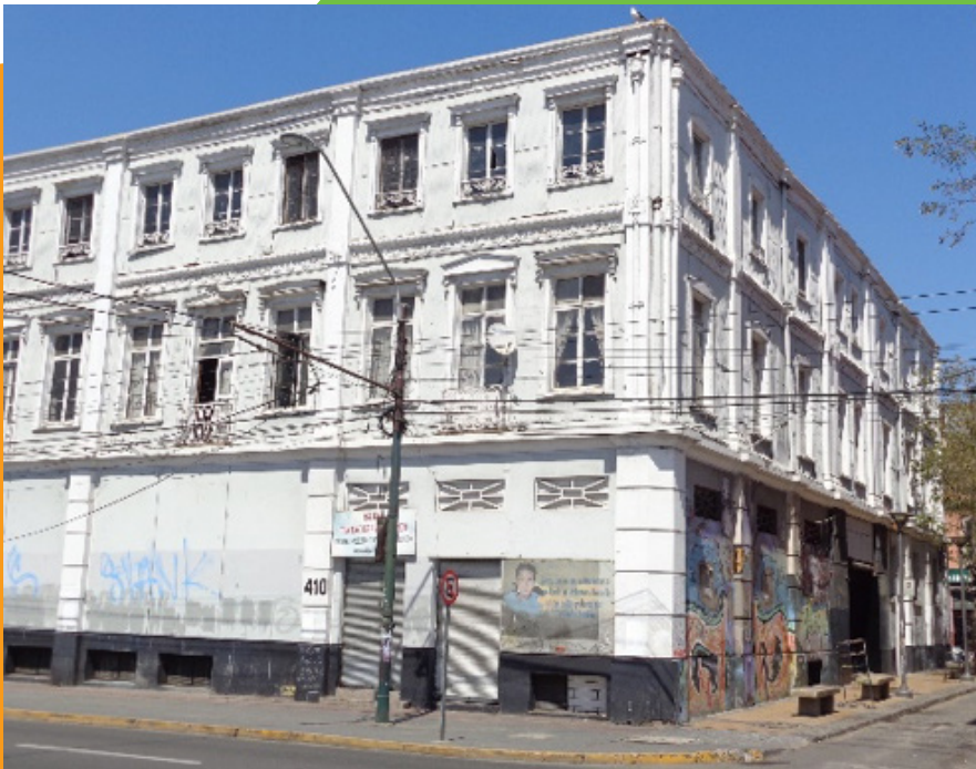
VISTA GENERAL EDIFICIO SINDICATO DE ESTIBADORES .
